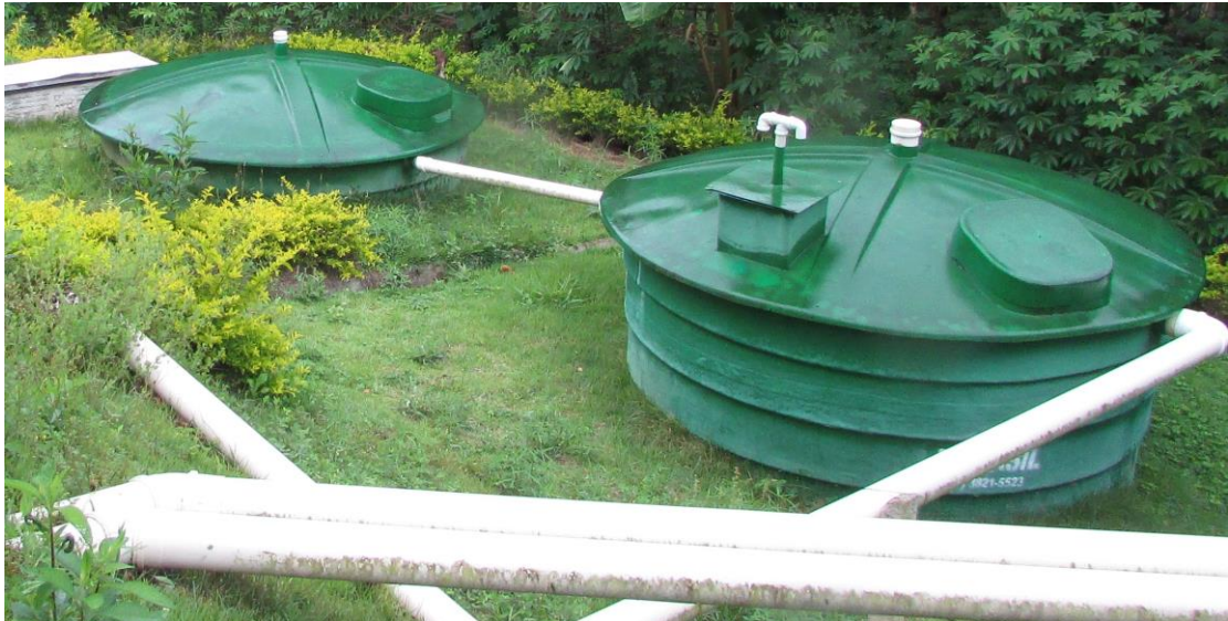
Figura 1. Sistema de Tratamento de Águas Residuárias composta por reator UASB seguido de Filtro Anaeróbio.
